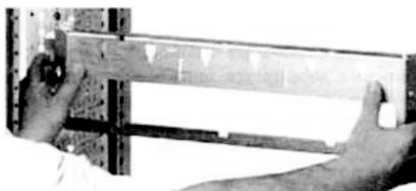
Рисунок 7.12 – Установка монтажной пластины
