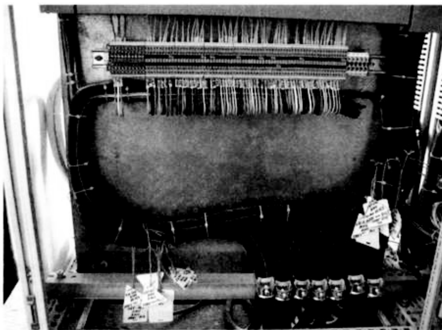
Рисунок 7.33 – Подвод контрольных кабелей снизу электроконструкции
